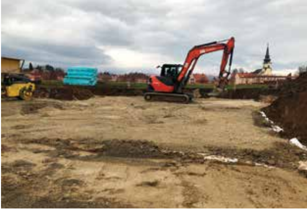
Iskop i stabilizacija terena nasipom šljunka kao podloge za mršavi beton.
