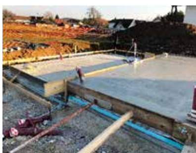
Temeljna je ploča izvedena u dva nivoa.
