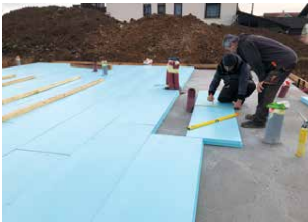
Polaganje prvog sloja toplinske izolacije FIBRANxps 400-L na podložni beton.
