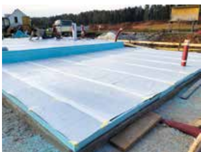
Na prvi sloj FIBRANxps 400-L položen je prvi sloj hidroizolacije FIBRANhydro 18 sk/sk
