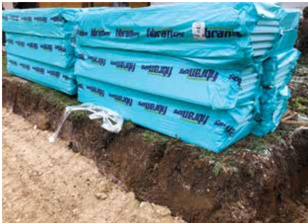
Ploče FIBRANxps 400-L i FIBRANxps SESIMIC 400-L čekaju ugradnju.
