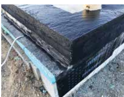
Posebna je pažnja posvećena detljima hidro-izolacije, prije izvedbe montažne drvene gradnje.
