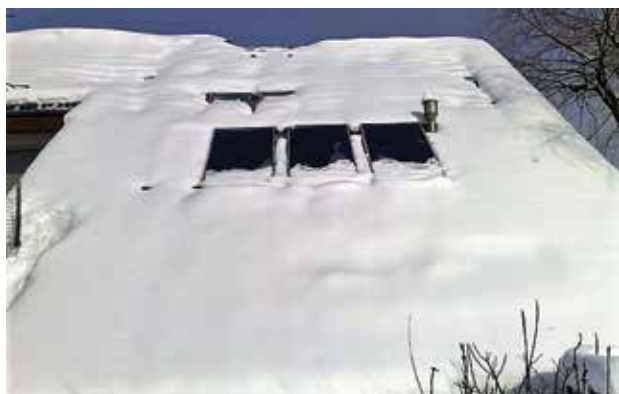
Slika 1: Velika količina snijega na krovu, koje se mjestimično neravnomjerno topi.
