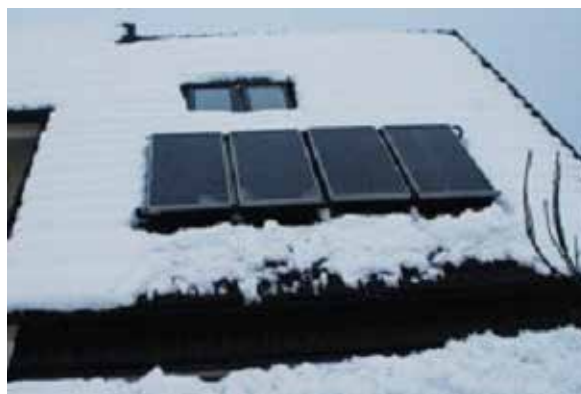
Slika 2: Toplinski saniran krov s tankim snježnim pokrivačem, koji se ravnomjerno topio uslijed povišene vanjske temperature.
