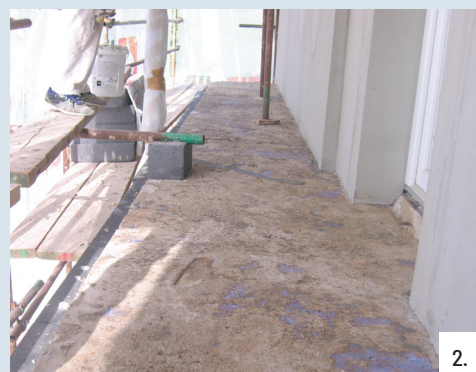
Postojeće stanje, nakon uklanjanja svih postojećih slojeva
