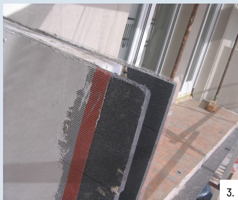
Bočni zid balkona moramo obložiti toplinskom izolacijom, da na taj način spriječimo nastajanje toplinskog mosta
