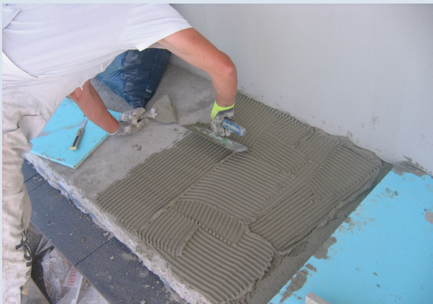
1. Na očišćenu površinu naneseemo mort za izravnavanje
