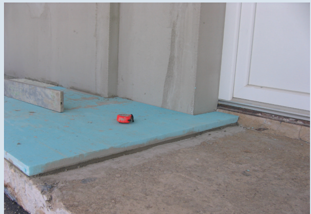
3. FIBRANxps ETICS zalijepimo na mortom obrađenu površinu
