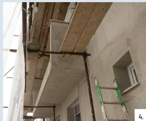
Bočni zid balkona moramo obložiti toplinskom izolacijom, da na taj način spriječimo nastajanje toplinskog mosta
