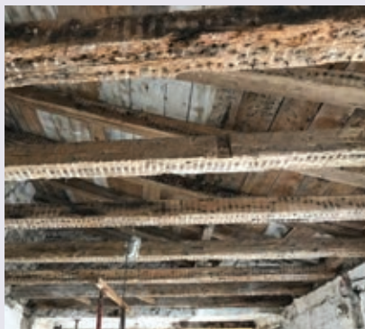
Dotrajale krovne grede koje se zamjenjuju
