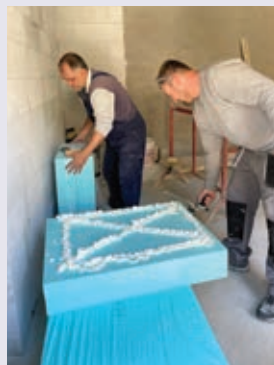
Nanošenje PU ljepila
