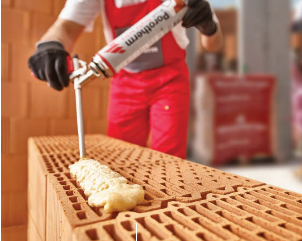
Zide od brušene opeke Porotherm Profi ili Porotherm IZO Profi, koja je međusobno povezana Porotherm Dryfix.extra ljepilom, ima veću vlačnu čvrstoću, a time i veću nosivost na sile potresa.
