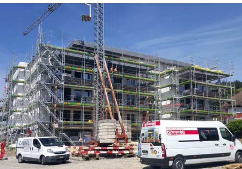
Montažna gradnja Domprojekt višestambene zgrade u Pfaffnau u Švicarskoj.
